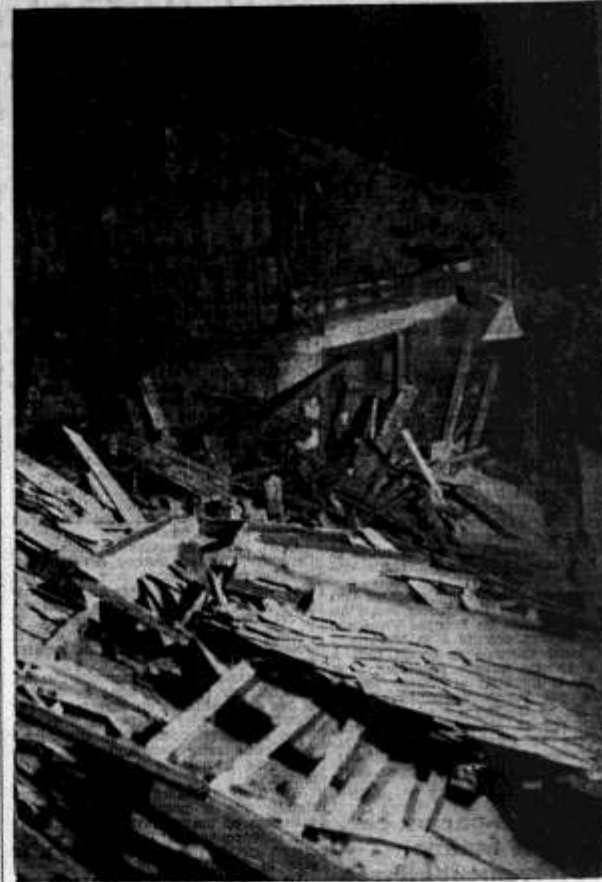
Dans l'enchevêtrement des poutres brisées.
